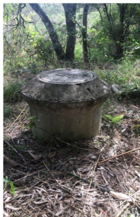
Várias caixas de passagem e inspeção de esgoto no seguimento da rede de esgoto existente.
