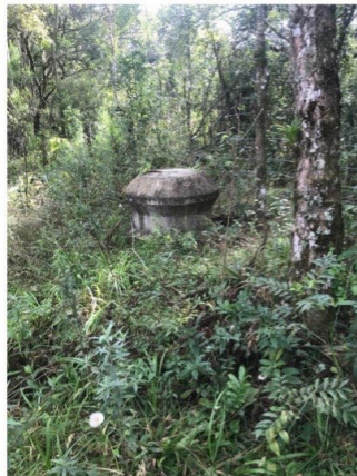
Várias caixas de passagem e inspeção de esgoto no seguimento da rede de esgoto existente.
